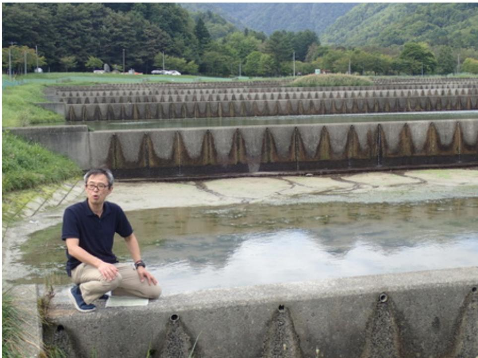
勇振川温水ため池。富良野盆地の南部は北部と違って比較的泥炭が浅いのですが、一方で空知川から取水する山部幹線用水が引かれるまでは水田稲作には冷たくて適さない芦別岳由来の雪解け水を用水として利用しなければならないのが悩みでした。このため池は雪解け水を温めながら利用するための仕組みです。面積は道内2番目、11面の遊水池の数は道内で最多です。
